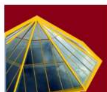
Рис. 1. Зенитный фонарь зимнего сада снаружи
